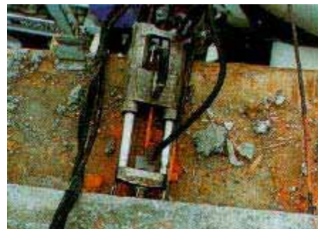
Macaco hidráulico de dois pistões efetua a protensão
