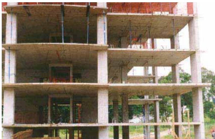
Edifício Residencial sem vigas
