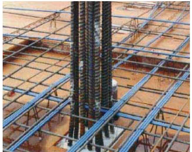
Armação do pilar engarrafada.
