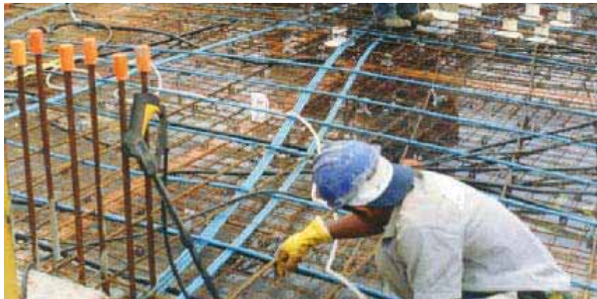
Exemplos de cordoalhas em uma laje
