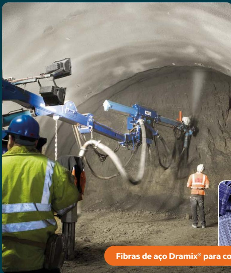
As **fibras de aço Dramix®** são aplicadas no compósito concreto reforçado com fibras. O objetivo é o controle da propagação de fissuras no concreto projetado, elevando a capacidade de controle e absorção de deformações (tenacidade).
