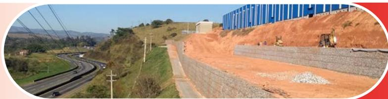
As contenções são soluções robustas de engenharia para estabilização de aterros, encostas naturais e taludes artificiais. Nesse contexto, os **Gabiões Belgo** proporcionam sólidas vantagens frente a obras tradicionais em concreto. Menor prazo de execução, simplicidade construtiva e **custo total reduzido** são alguns exemplos.
