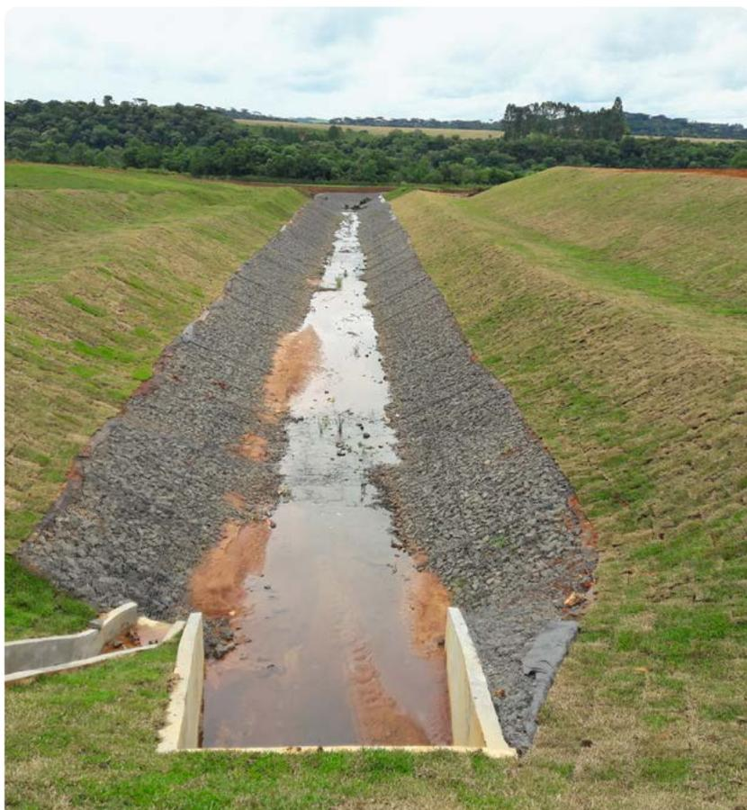
As obras hidráulicas são necessárias para o controle do fluxo de água e prevenção de processos erosivos. Seja no contexto urbano ou rural, os **Gabiões Belgo** são aplicados na forma de escadas hidráulicas, canais, proteção de margens e calhas de rios, córregos, lagos e barramentos.
