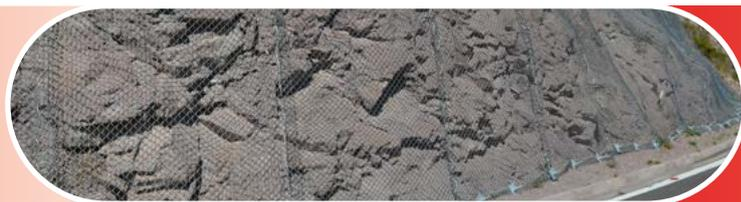
As **Telas Metálicas Belgo de Alta Resistência** são soluções de engenharia delgadas e de alto desempenho para estabilização e proteção de encostas naturais e taludes.
