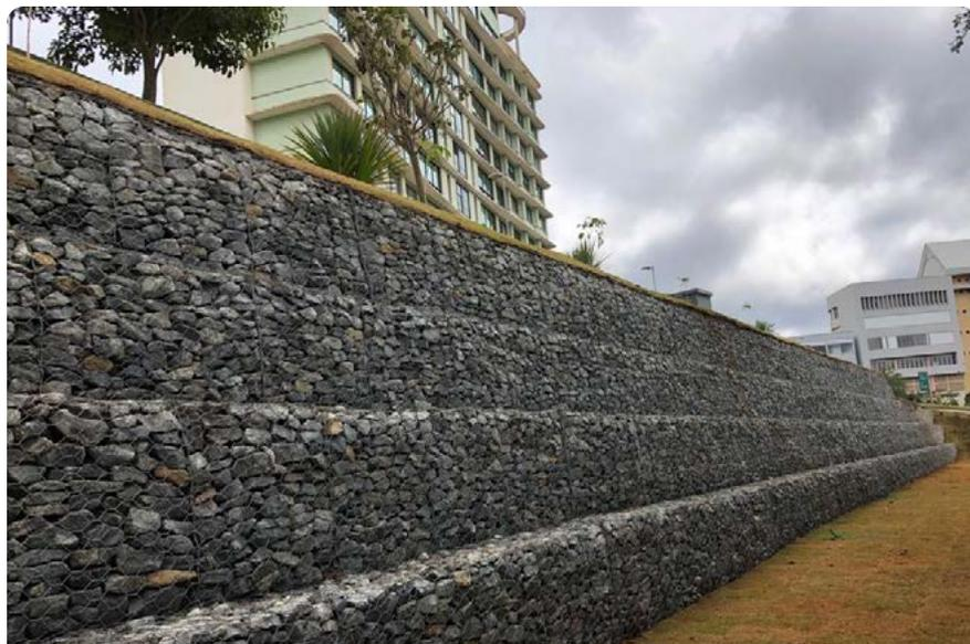
Contenção com Gabiões Belgo tipo Caixa
