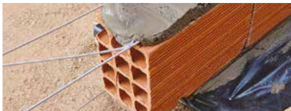
Demonstração do correto posicionamento do Murfor®
