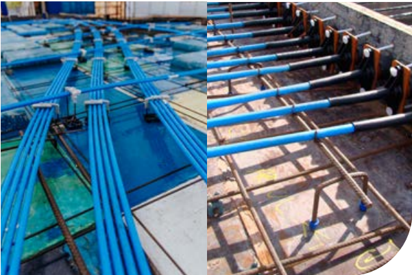
Lajes de edifícios
